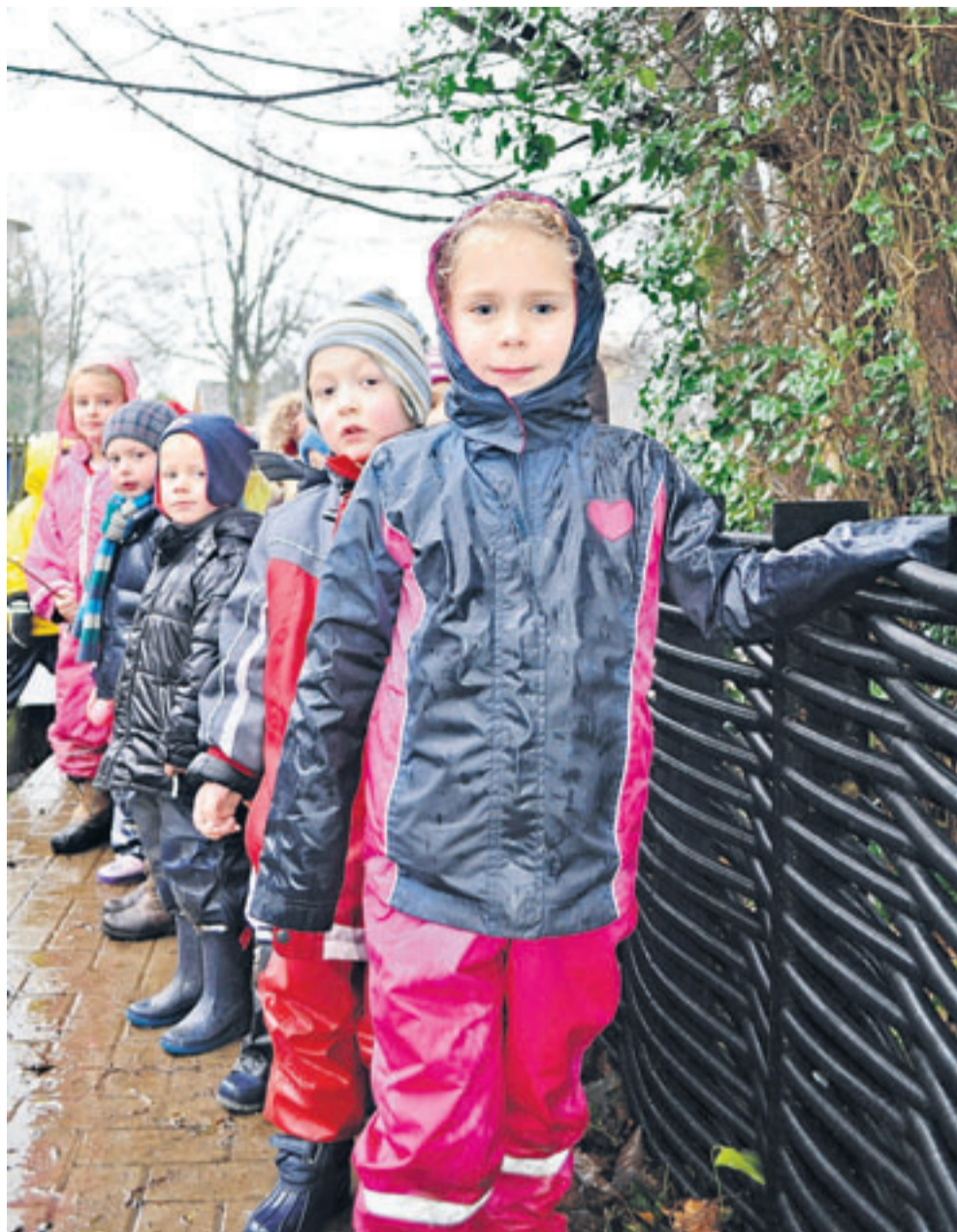
Hier kommt die Wärme aus der Erde: Die Kinder stehen am 25 Meter langen Zaun aus schwarzen Plastikrohren. Ein Drittel steckt im Boden, gefüllt mit Frostschutzkonzentrat. FOTO: SCHELLER
